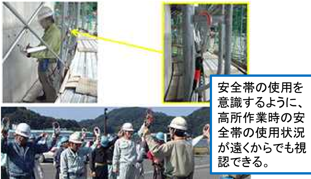
【蛍光シールによる安全帯使用状況の見える化】
