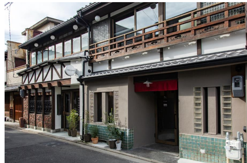
建物外観（改修後）
