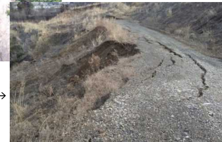
亀裂に沿って段差が生じはじめる等、崩壊し始めており、危険な状態。
