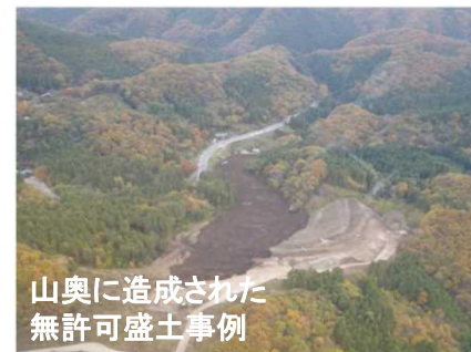
斜面地の谷を埋め、土砂が崩落した事例
