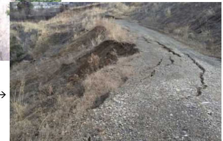
亀裂に沿って段差が生じ始める等、崩壊し始めており、危険な状態。
