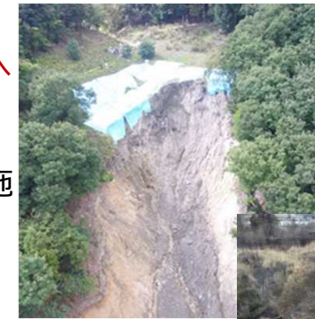
←既に盛土の崩壊が発生し、崩壊土砂が不安定な状態で堆積しており、二次災害の発生や被害の拡大のおそれがある危険な状態。
