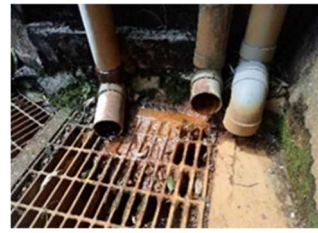
(d) 水抜き穴からの湧水 (鉄分を含むことを示 唆する赤褐色物質が沈積)
