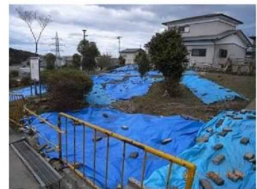
図参2-② 局所的なり面崩壊
