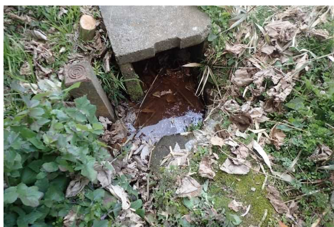
図 8.5 盛土のり尻の排水工からの排水状況確認の例
