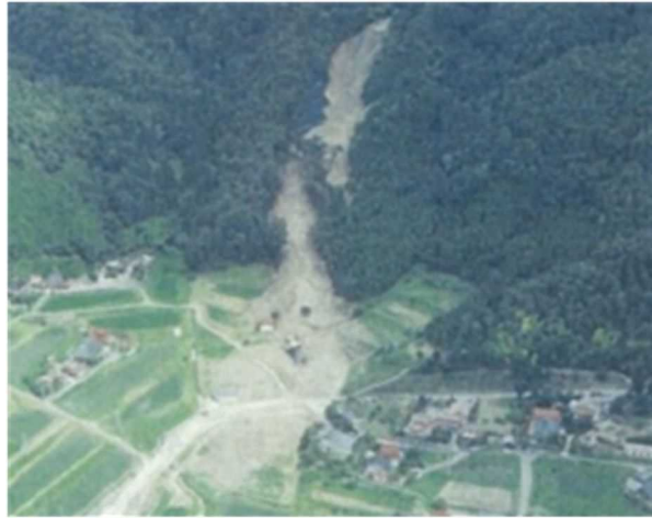
図参 1.1.2 盛土の崩落により流出した土砂が土石流化した様子
