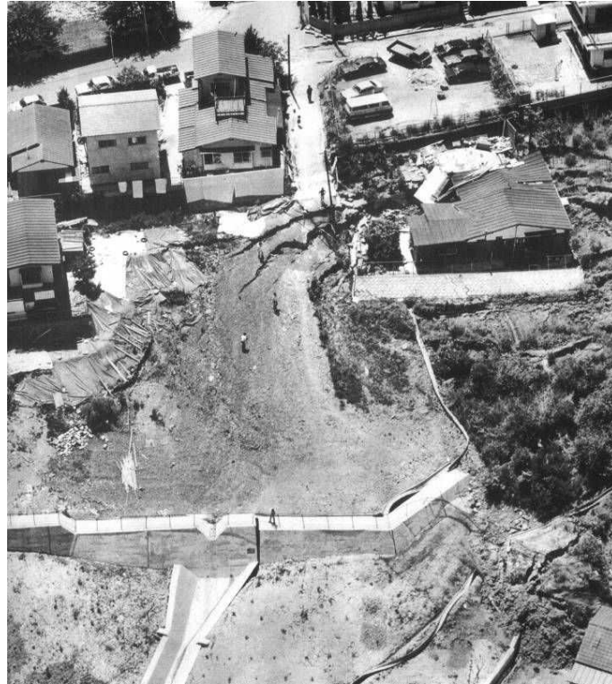
図参 1.1.4 1978年宮城県沖地震による盛土造成地の被害 (撮影、提供：河北新報社)
