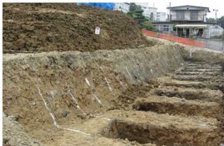
図参 5.1.3 固結工法（中層混合処理工）の施工状況（N地区の例）
