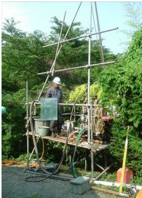
図参 7.4.1 調査ボーリング実施風景
