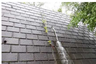
降雨終了直前（擁壁水抜き穴から出水）
