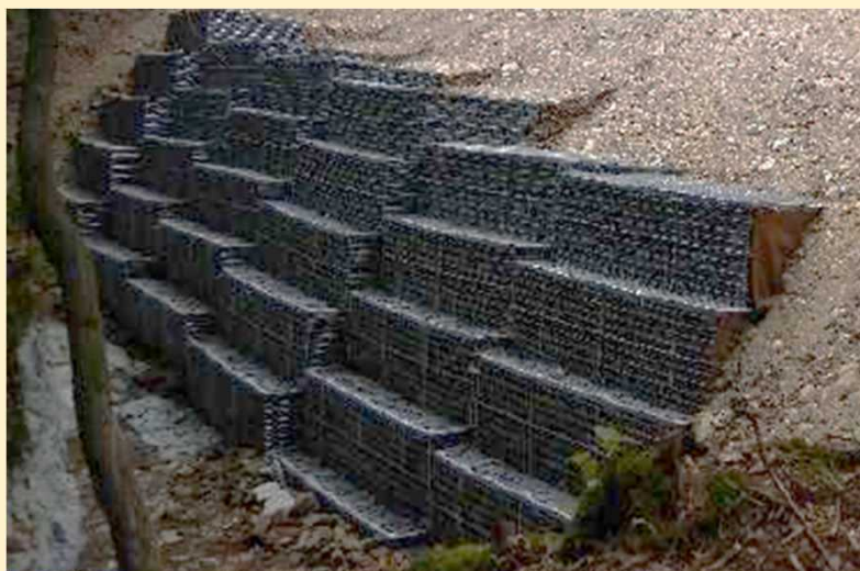
大型かご枠工
