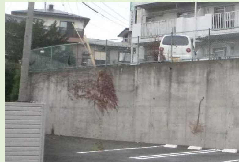
コンクリート擁壁
