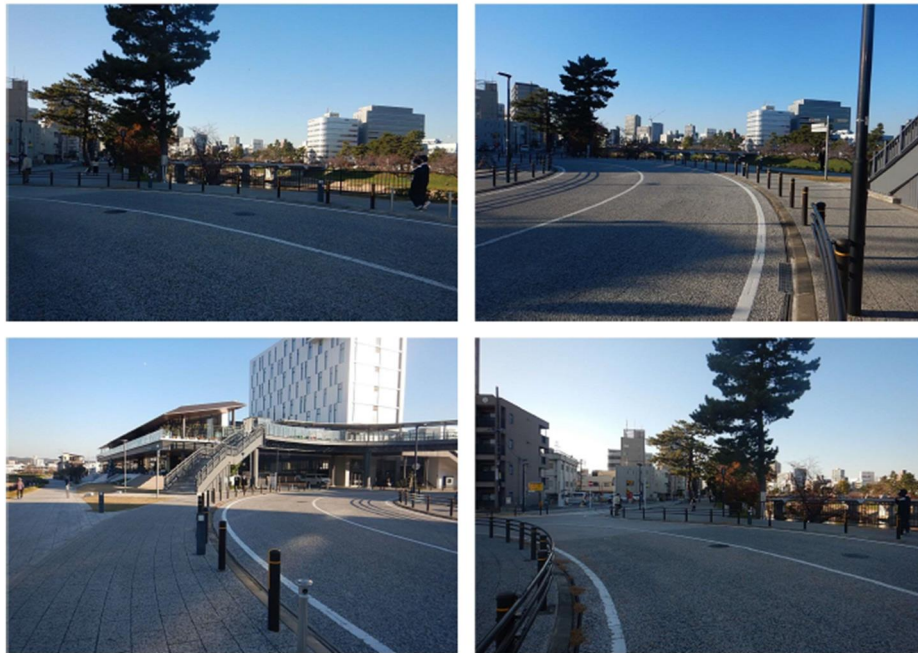
図 5-5 ボラード撤去の様子
