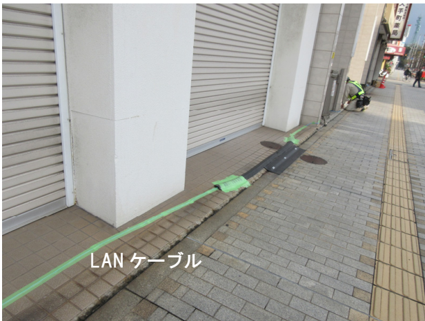
図 3. 4. 6 LAN ケーブルの配線・PC ボックスの設置状況例
