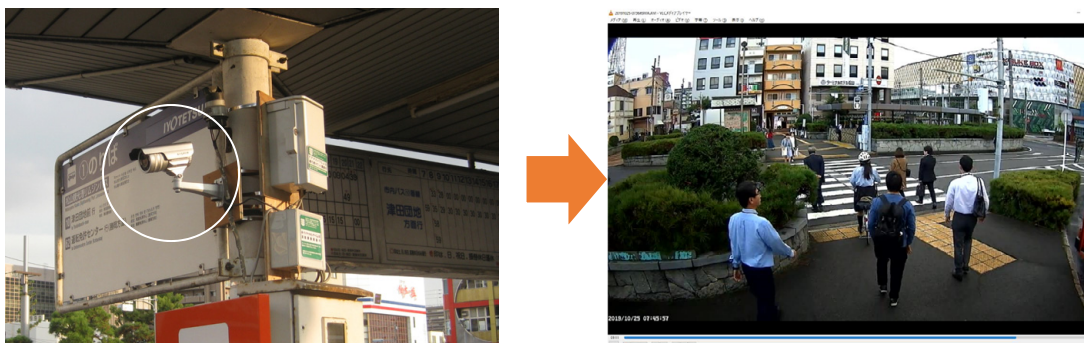
図 3.1.3 機器設置状況とカメラ画角
