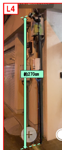
図 3.4.4 レーザーセンサーの設置状況（大手町通り北側一東）
