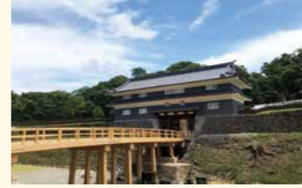
復原された鼠多門、鼠多門橋
