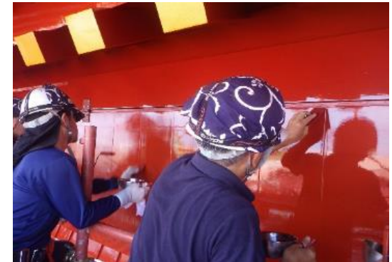
正殿の外壁塗替え(H30年度)
