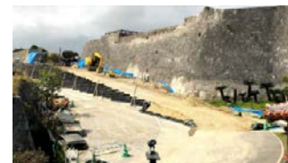
◀工専用仮設道路の設置
