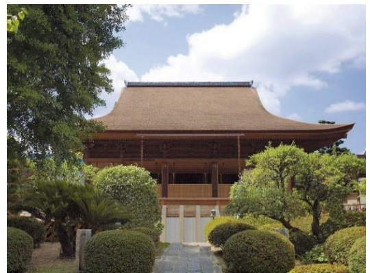
檜皮葺の屋根が美しい 重要文化財『龍福寺本堂』
