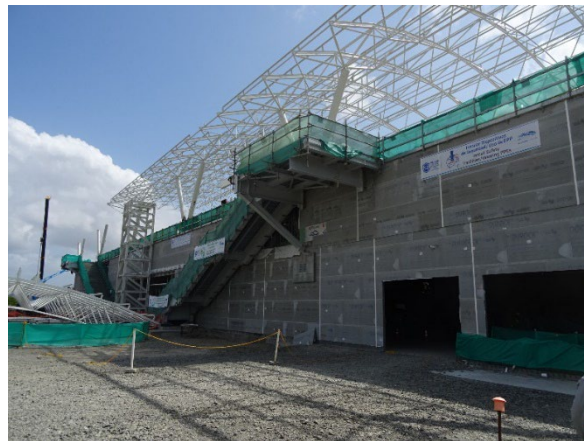
西端のCiuda del Futuro駅 ホームは長さ100m、プラットホームスクリーンドアを備える。 今後、側面にもスペースフレームを設置する。
