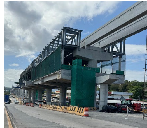
道路中央の高架駅 鋼製のBOXの上がホーム階
