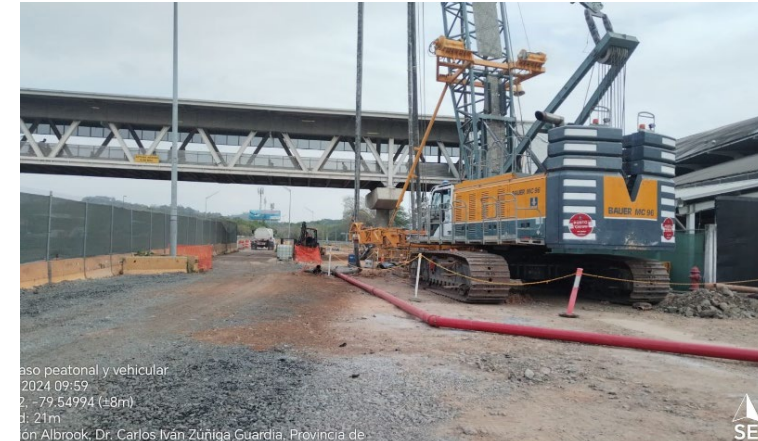
運河東側のターミナルであるAlbrook駅 では掘削工事が進行中
