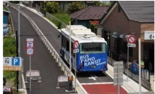
図 日立 BRT 専用道
