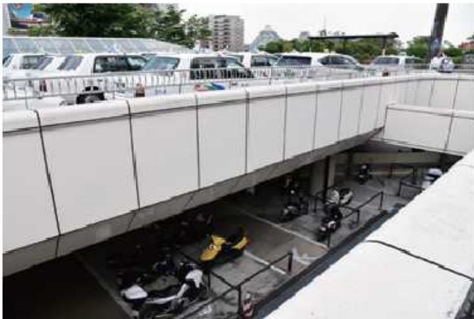
2階はタクシープール
