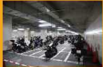
山口県：産業通商部地下自転車駐車場 地下道の敷設に合わせて、市中心部の地下に大規模な二輪車駐車場を建設した。
