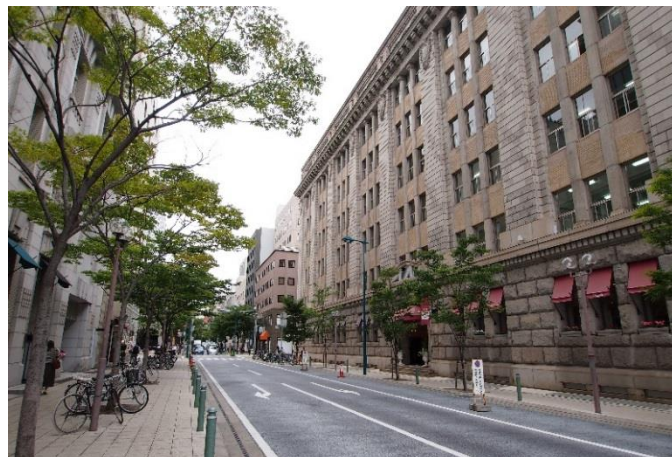
神戸市 旧居留地 (景観形成地域による駐車場出入口設置規制)
