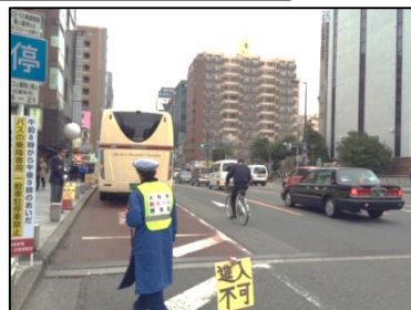
② 交通誘導員の配置
