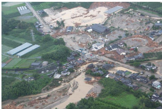
図-1 市内の被災状況
