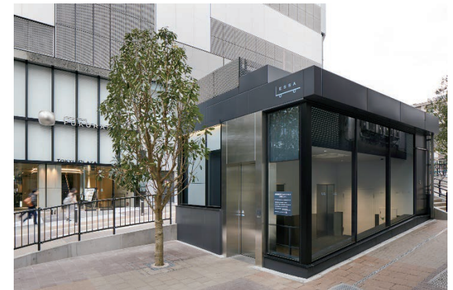
写真：地域荷さばき専用エレベーター
