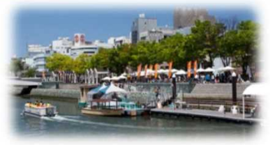
親水護岸の利用 (新町川 / 徳島市)
