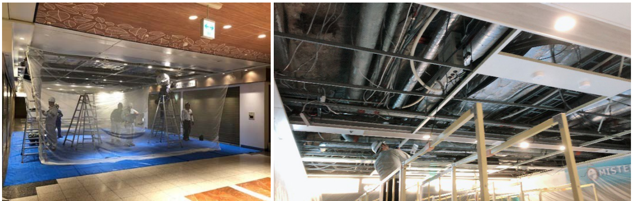
写真1.2 天井板を外した状態での天井内目視調査（セントラルパーク地下街）
