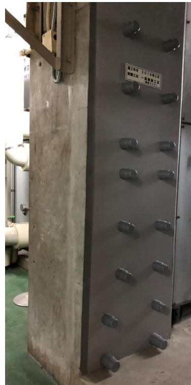
写真2.3 耐震補強工事一面補強工法（鋼板タイプ）の実施例（サカエチカ）
