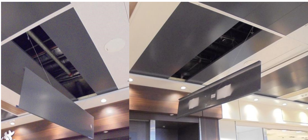
写真2.7 地下街防災推進事業で実施した軽量天井パネルと落下防止ワイヤーの設置状況 (セントラルパーク地下街)
