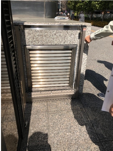
写真2.8 左：止水板取付前 右：止水板取付後（名古屋地下街（サンロード））
