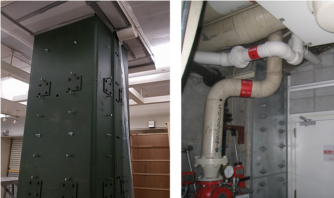
写真2.5 耐震補強工事の実施例
