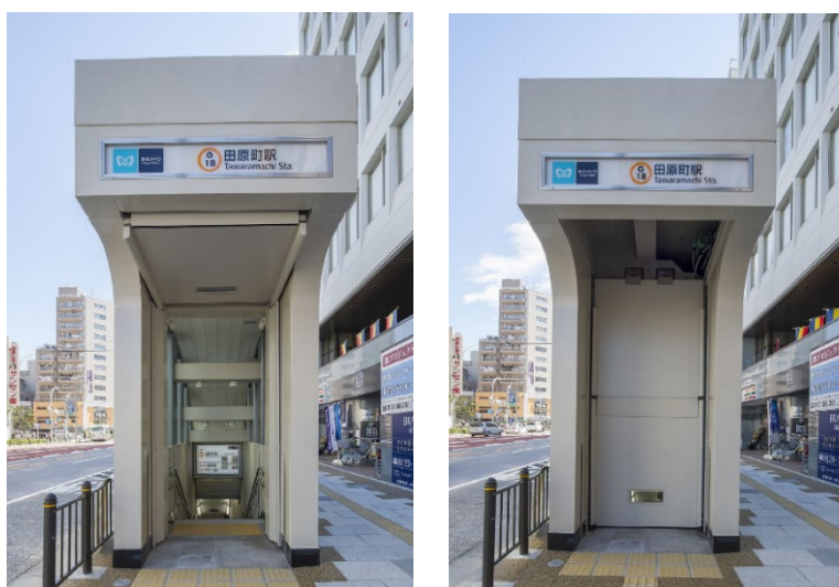
写真2.9 防水シャッター兼用の管理シャッターを付けて改造した地上出入口（東京メトロ 田原町駅）
