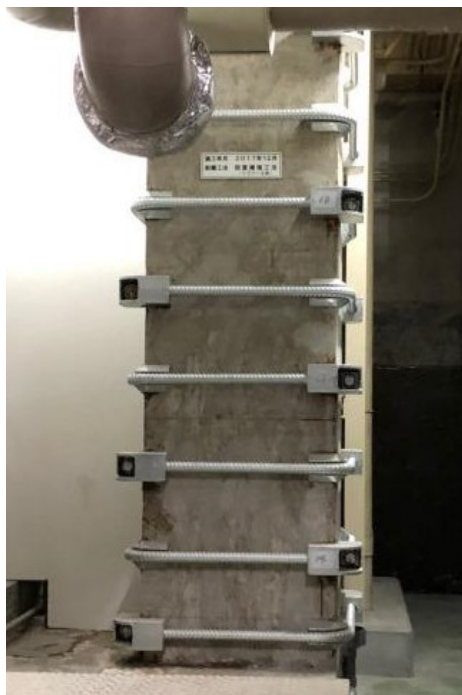
写真2.4 耐震補強工事（リブバー工法）の実施例
