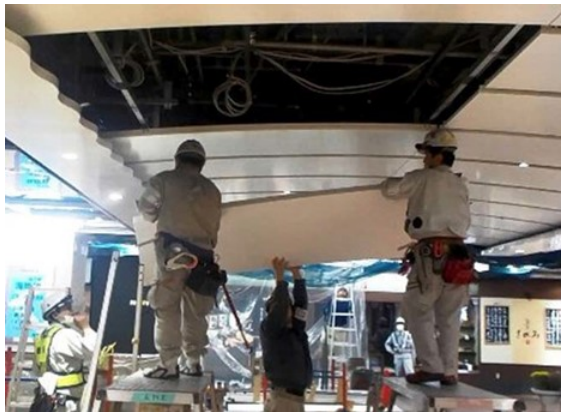
写真2.6 左：軽量天井板取付状況
