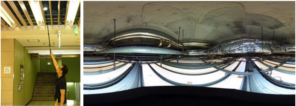
写真1.1 維持管理：全方位カメラを利用した天井内部調査（エスカ）
