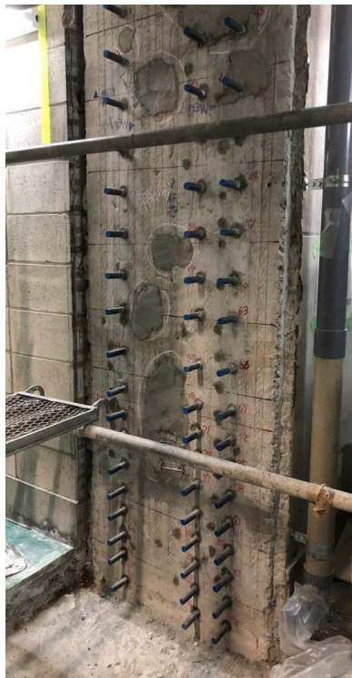
写真2.3 耐震補強工事一面補強工法（鋼板タイプ）の実施例（サカエチカ）
