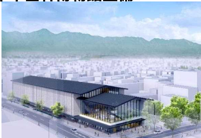
R2.3着工→R5開館予定
