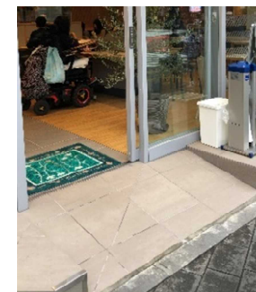
スロープの設置
