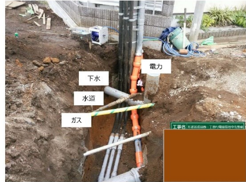
22年10月11日～10月25日（電力・通信工事）
