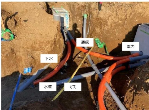
22年10月17日～22年12月20日（電力・通信工事）
