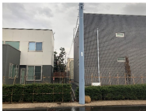
写真：通信線の裏配線
