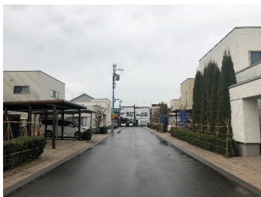
写真：直接埋設による地中化
