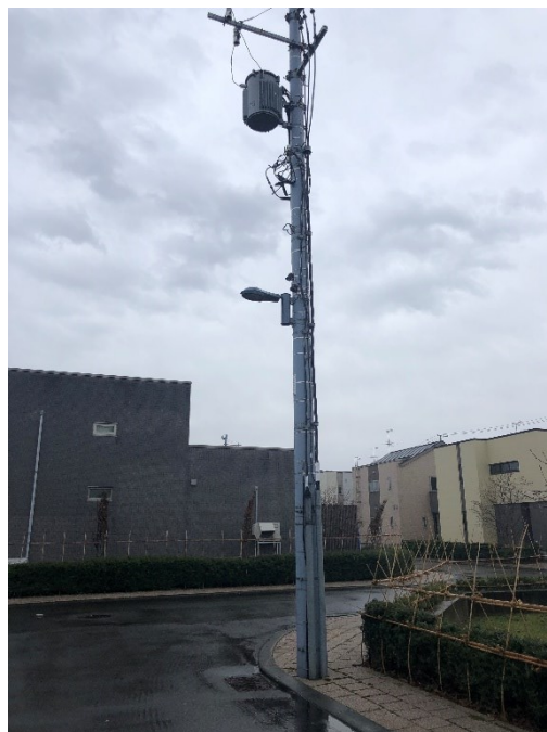
写真：ソフト地中化方式の採用事例（北海道旭川市）
