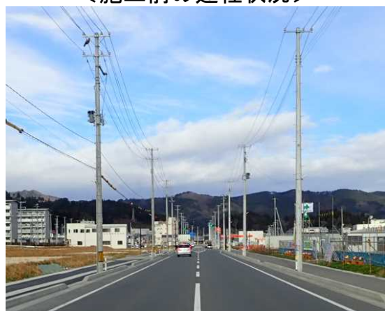
<施工前の建柱状況>
