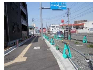
常設作業帯を確保し昼間で施工
