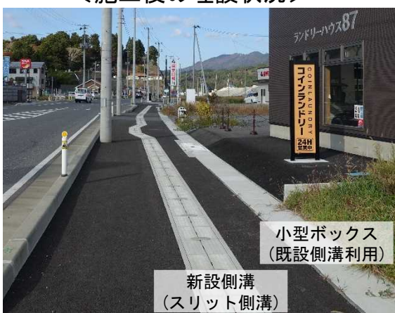
<施工後の埋設状況>
