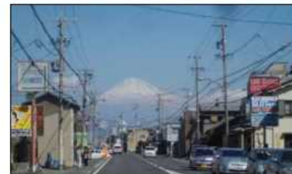
<美観を損ねる電柱・電線>
