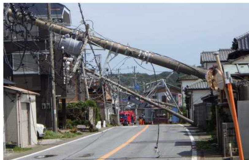
2019年台風第15号による電柱倒壊
