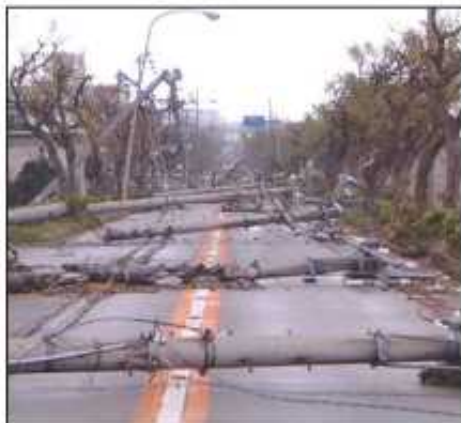
<電柱の倒壊による道路閉塞>
