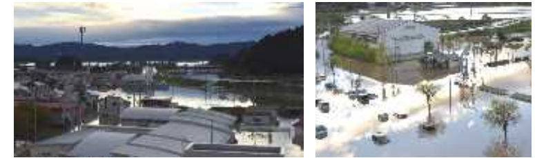
令和元年東日本台風において丸森町役場が冠水し、アクセス困難な状況となり、通信手段が防災無線のみに限られる時間が継続。
