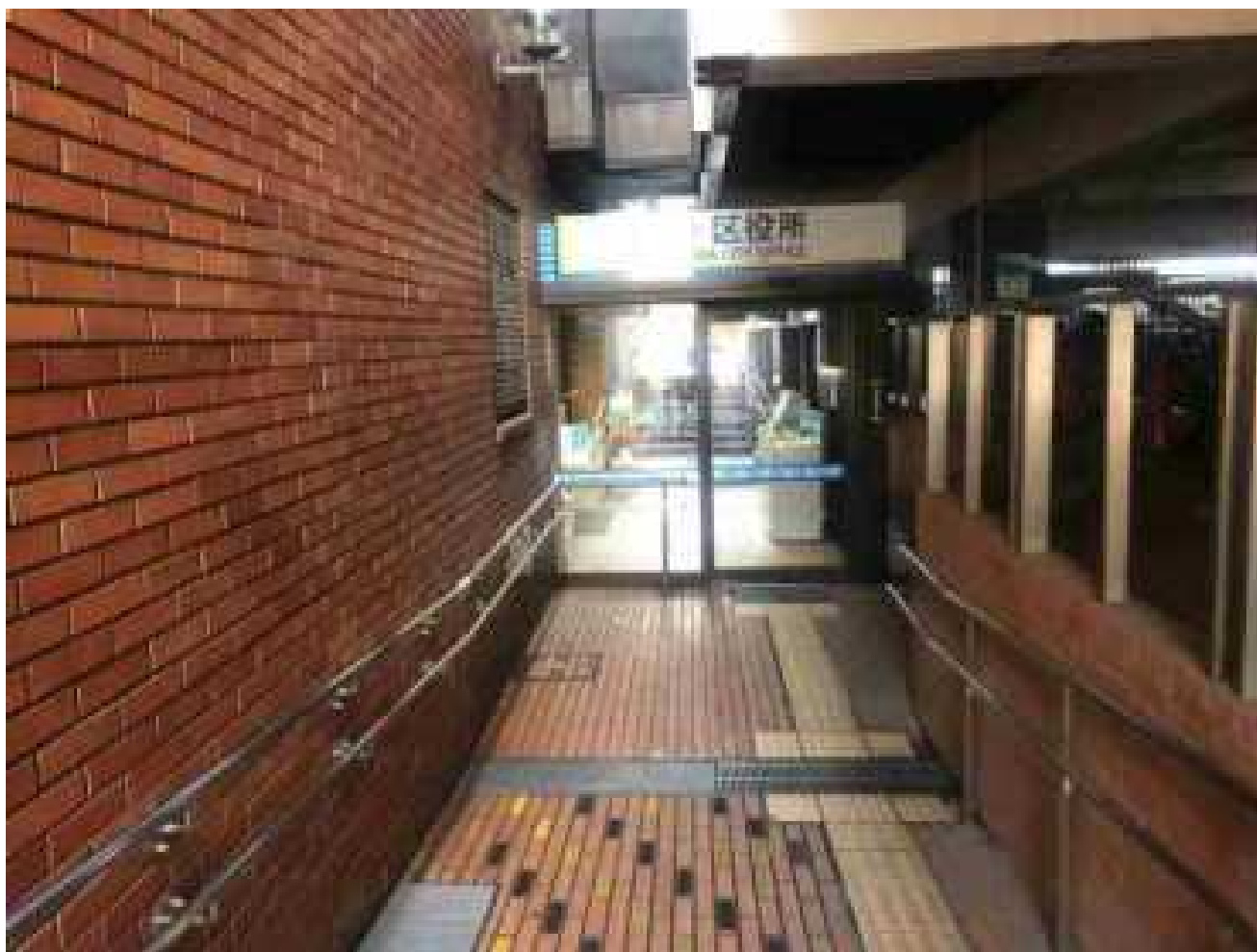
葛飾区区役所新館1階入口(昭和53(1978)年建築)
