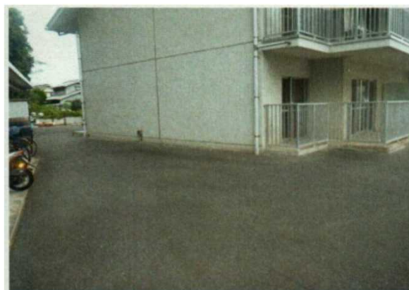
施工箇所② 施工前
