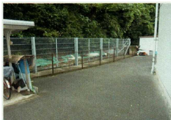
施工箇所① 施工前
