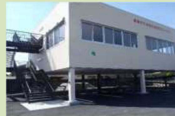
浸水を想定したピロティー形式の防災センター 【豊橋市】
