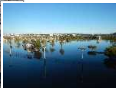
台風第19号時の貯留状況
