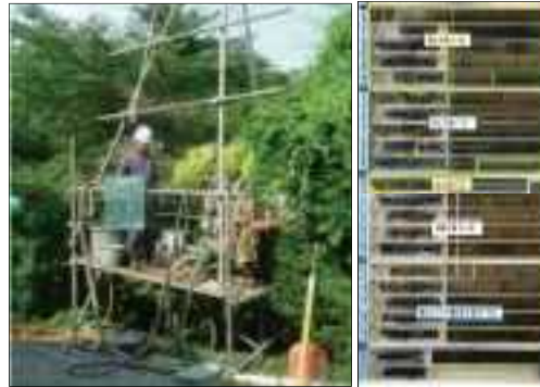
盛土ごとの安全性を調査
