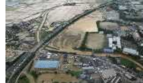
④ 桂川における浸水被害 (福岡県朝倉市)
