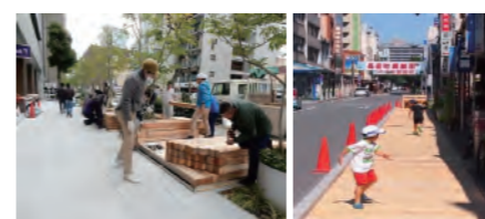
ウッドデッキによる歩道拡幅
