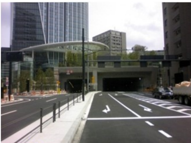
〈Ⅲ街区環状第2号線地下トンネル出入口〉
