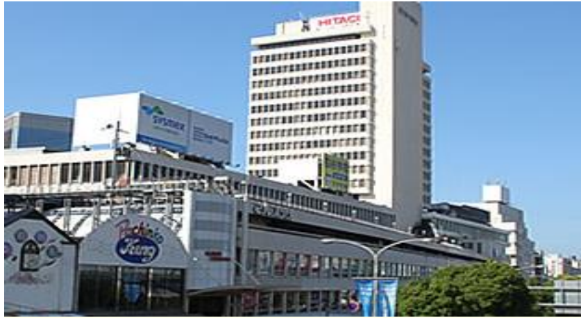
中央幹線沿い（外観）
