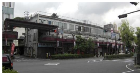
防火建築帯 (岐阜県大垣市)
