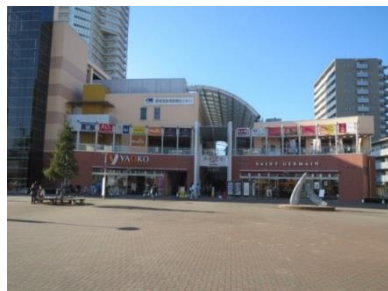
整備後利活用が図られていない広場
