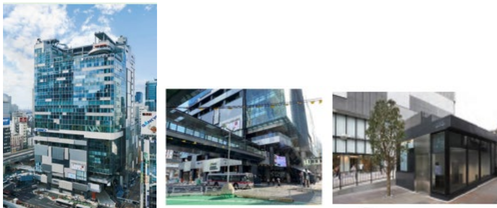
図 参考資料 1-3 「渋谷フクラス」(外観、バスターミナル・歩行デッキ)
