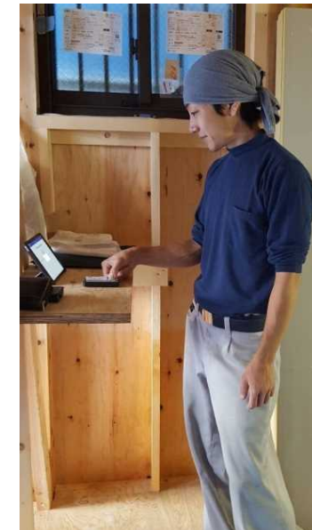
戸建住宅現場の屋内にiPadを設置
