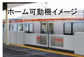
ホーム可動柵(4線に新設)
