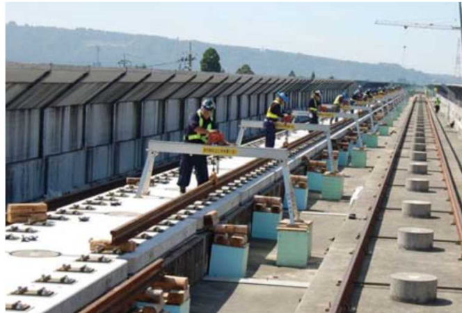
レール運搬・敷設状況
