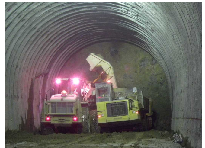
発生土をダンプに積み込んでいる状況
