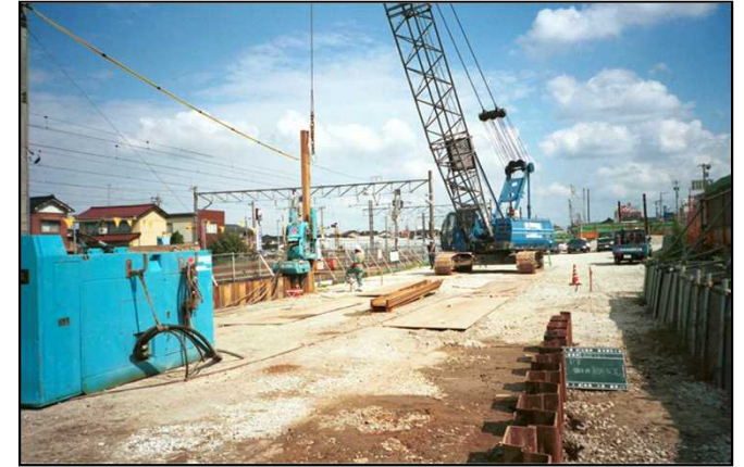
鋼矢板打ち込み作業状況
