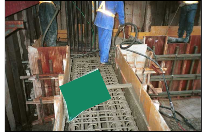
基礎コンクリート打設状況
