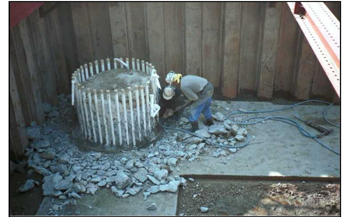
杭頭処理状況
