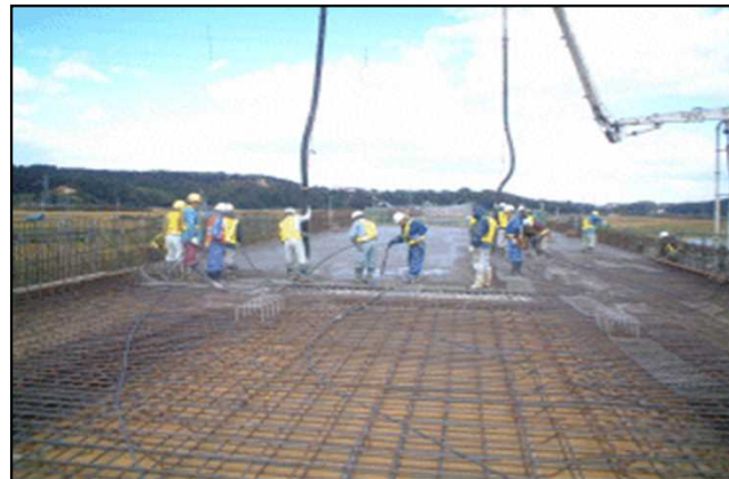
高架橋スラブコンクリート打設状況
