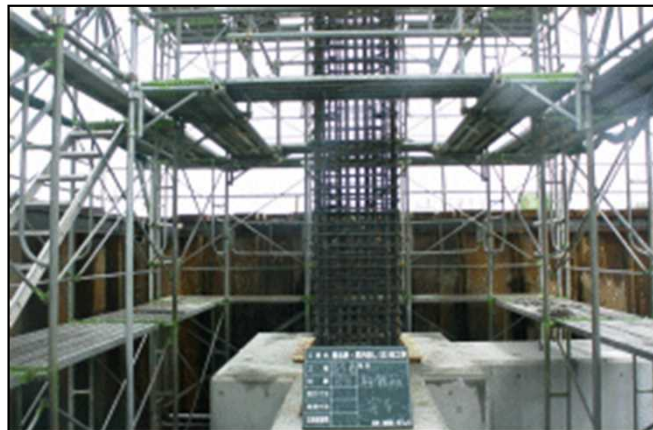
柱鉄筋組立状況
