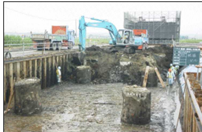
床掘作業状況
