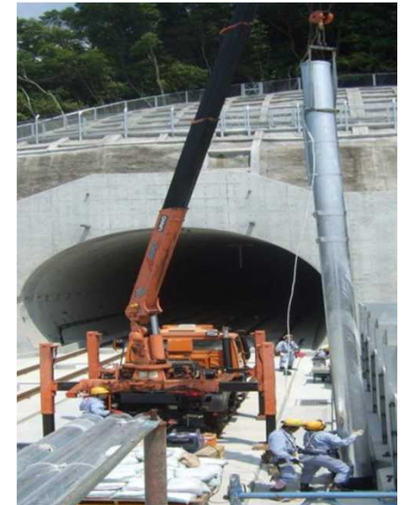
①支持物の取付(鋼管柱の建植)
