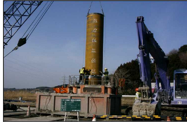
ケーシング建て込み作業状況
