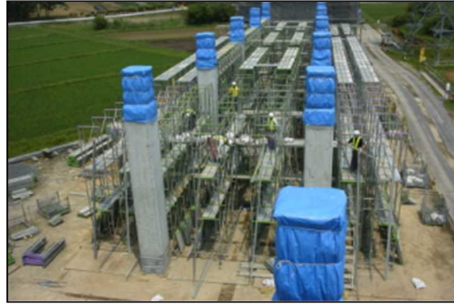
足場・支保工組立状況
