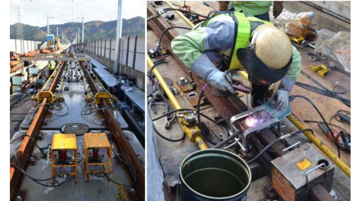
レールの三次溶接状況
