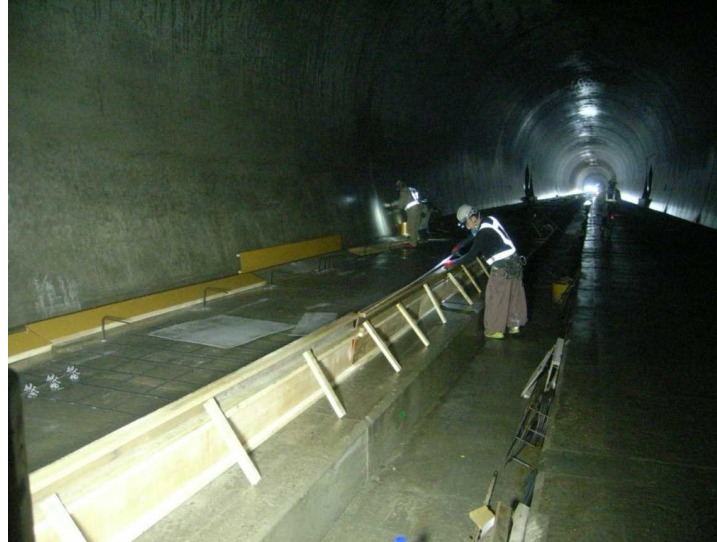
側部型枠設置状況
