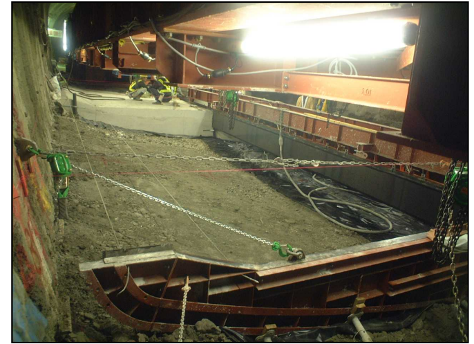
掘削作業完了状況
