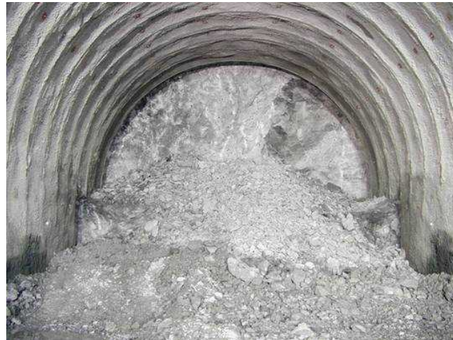
爆薬を爆破させた直後の状況
