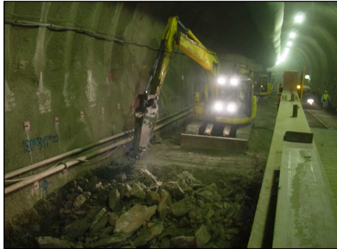
掘削作業箇所の後方において、重機(ブレーカー)による掘削作業状況
