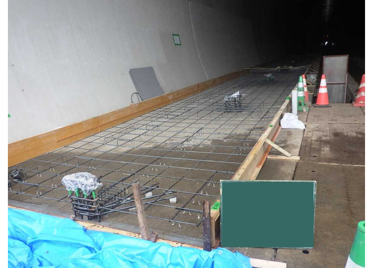
路盤・突起コンクリート 鉄筋組立状況
