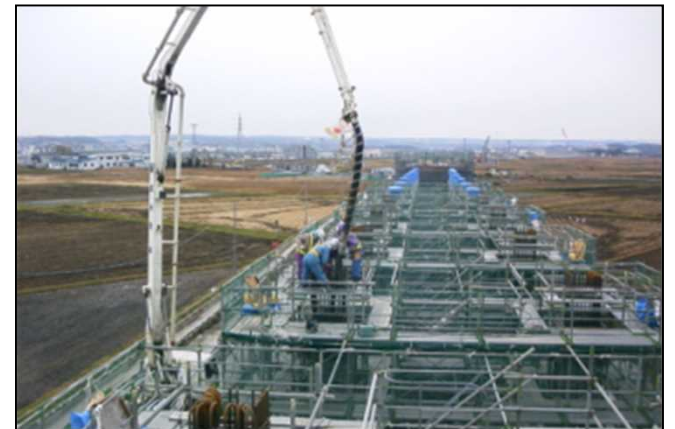
柱コンクリート打設状況
