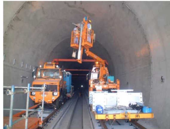
①支持物の取付(下束の取付)
