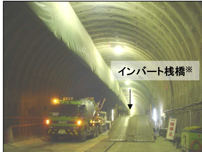
コンクリートの打設状況
