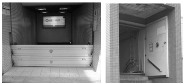
止水板・防水扉の整備
