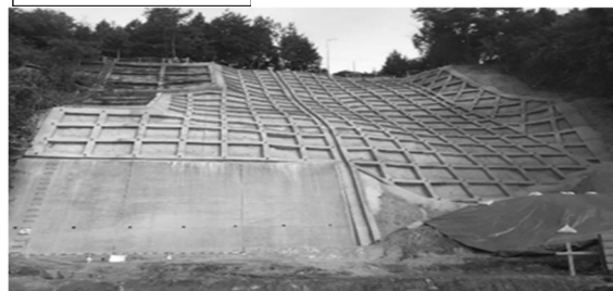
コンクリート枠による斜面の補強
