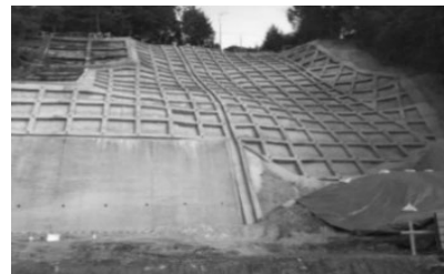
斜面の補強
