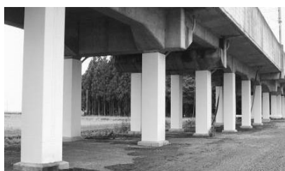
鋼板巻きによる高架橋の耐震対策
