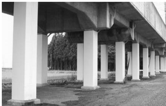
鋼板巻きによる高架橋の耐震対策
