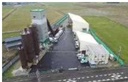
あわら市内の仮設プラント
