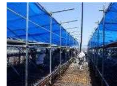
雨天時打設対策の実施状況
