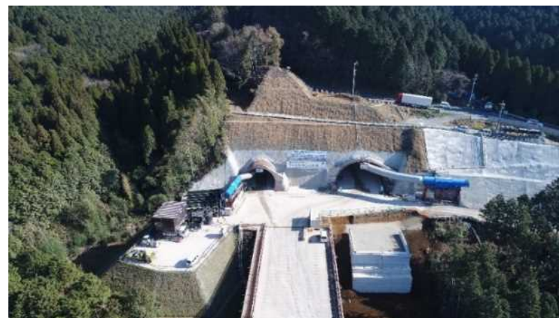
二重峠トンネル(大津工区坑口付近)
