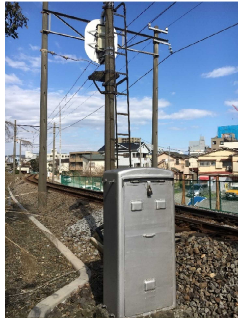
無線機設置箇所調査
