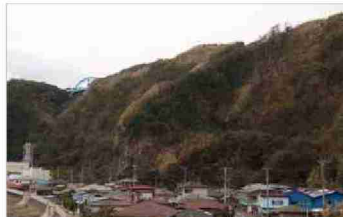
● 土砂流出防備保安林 表土の侵食による土砂の流出を防止
