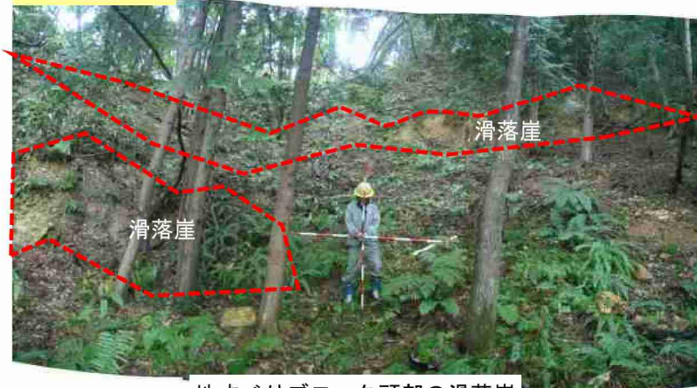
地すべりブロック頭部の滑落崖
