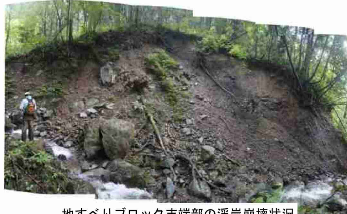
地すべりブロック末端部の溪岸崩壊状況
