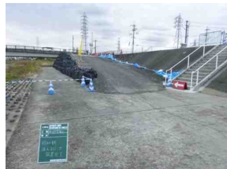
工作物の設置(仮進入路)
