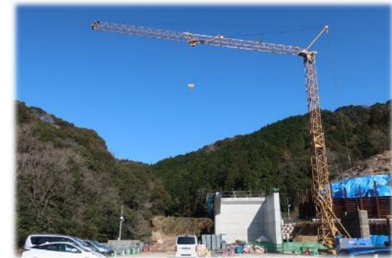
定置式水平ジブクレーン
