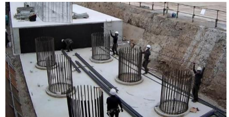
鉄筋の人力による施工ヤード内運搬(現状)
