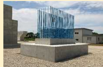
▼ 橋脚配筋模型
