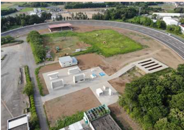
▲建設DX実験フィールド全景
