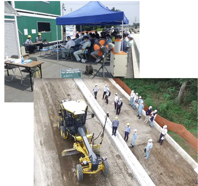
R2年度 道路改築工事における現場見学会 (飯能県土整備事務所管内)
