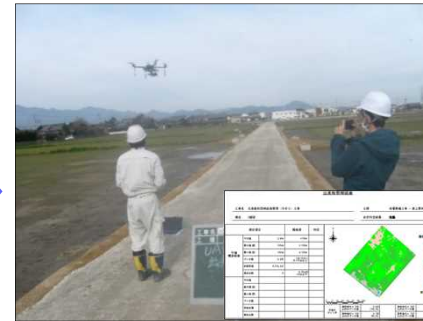
UAVによる出来形管理
