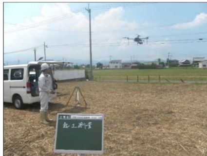
UAVによる3次元起工測量
