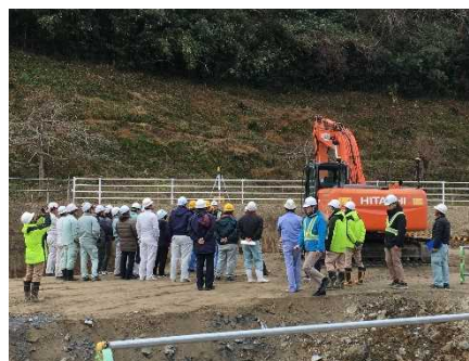
ICT建設機械施工実演
