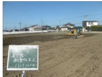
MCブルドーザによる表土整地
