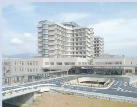
静岡県立静岡がんセンター
