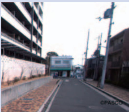
図2 MMSにより撮影された映像
