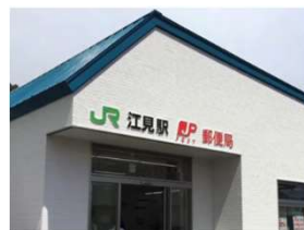
駅舎の 新改築・移設
