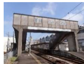
既存施設の 撤去
