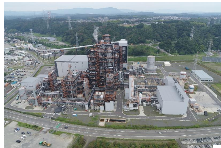
▲勿来IGCC(提供元: 勿来IGCCパワー合同会社)
