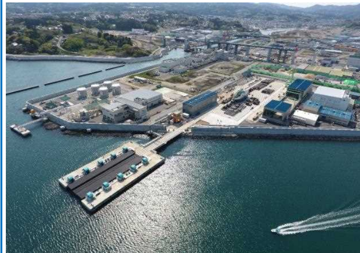
みらい造船所新工場全景
