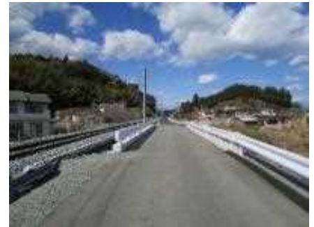
高線量区間の避難用道路の整備
