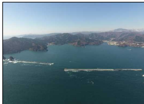
釜石港 (湾口防波堤全景)
