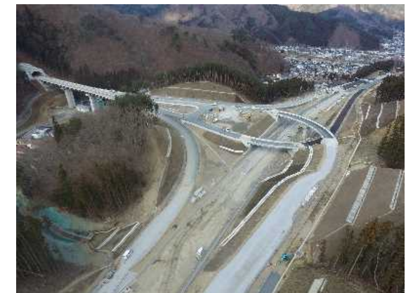
三陸沿岸道路 釜石南～釜石両石(釜石JCT) (2019.1現在)
