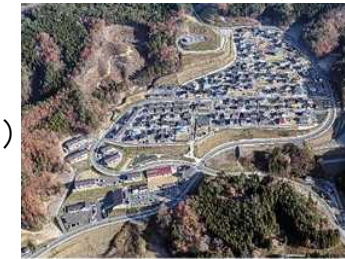
防災集団移転促進事業 （岩手県宮古市田老地区）
